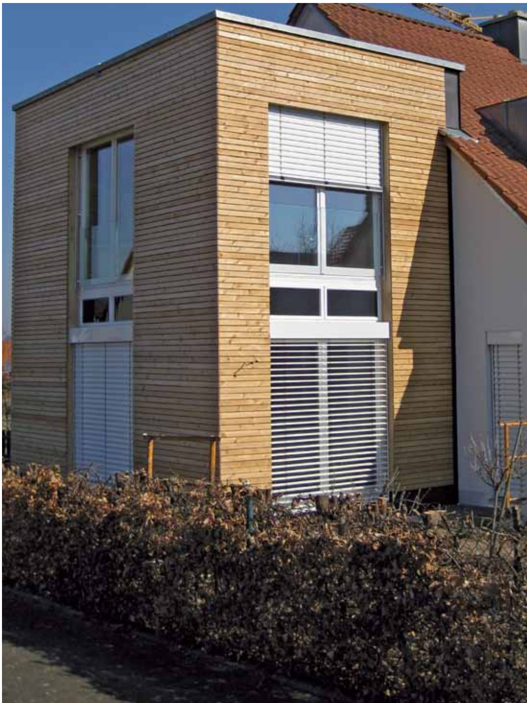
Sibirische Lärche, Rhombusprofil, gehobelt, 26 x 65 mm
